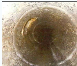
老朽化した管（施工前）
